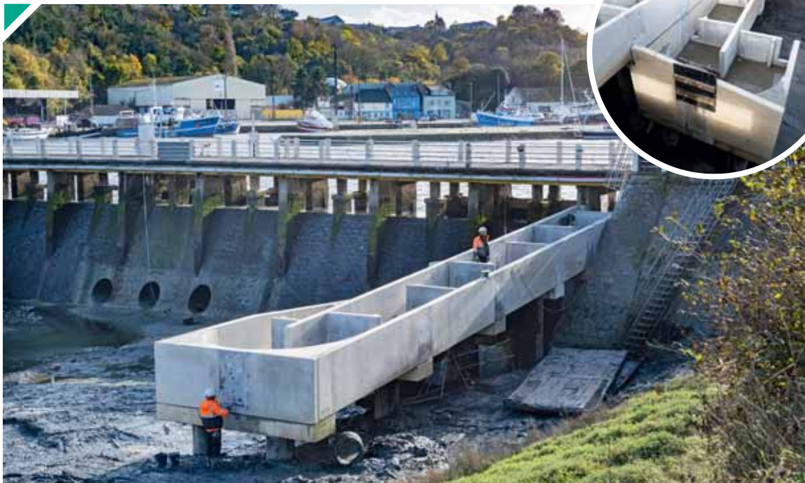
Une série de 10 bassins doit permettre aux poissons de remonter tranquillement vers le port.
