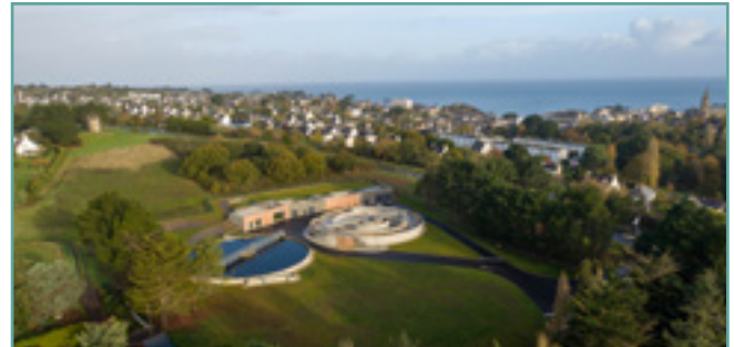
La nouvelle station d'épuration de Saint-Quay Portrieux achevée en 2022
