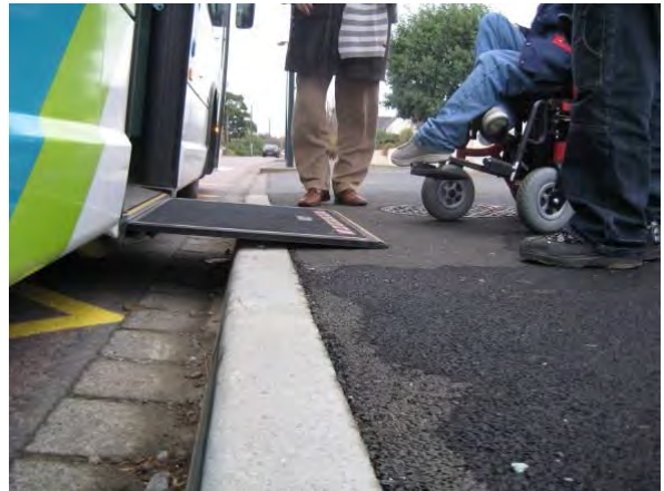
Arrêt Coteaux de l'Etangs (PORDIC) 16cm – Rampe+agenouillement du bus : accessible
